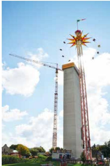
Der freistehende Kran verfügt über 50 m Ausladung und 6 t Tragkraft. (Foto: BKL)
