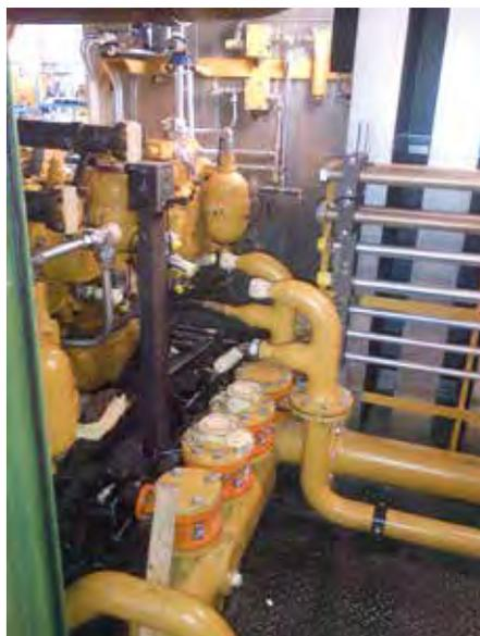
*Die Hydraulikanlage für die Unterwasserfräse wurde für drei Zwei-Zoll-Vorlaufleitungen und drei Zwei-Zoll-Rücklaufleitungen und einem maximalem Druck von 340 bar ausgelegt.*
