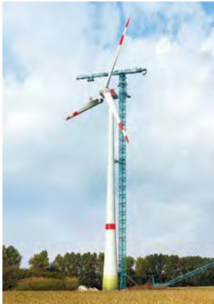
*Der neue Flat-Top-Kran ist bei der Montage einer Enercon-Windkraftanlage mit 135 m Nabenhöhe mit nur einer Abspannung auf 149 m Hakenhöhe geklettert. (Fotos: Liebherr)*
