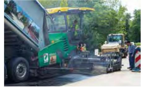
Die neue Ausziehbohle AB 500 TV ermöglichte den perfekten Einbau der Deckschicht.
