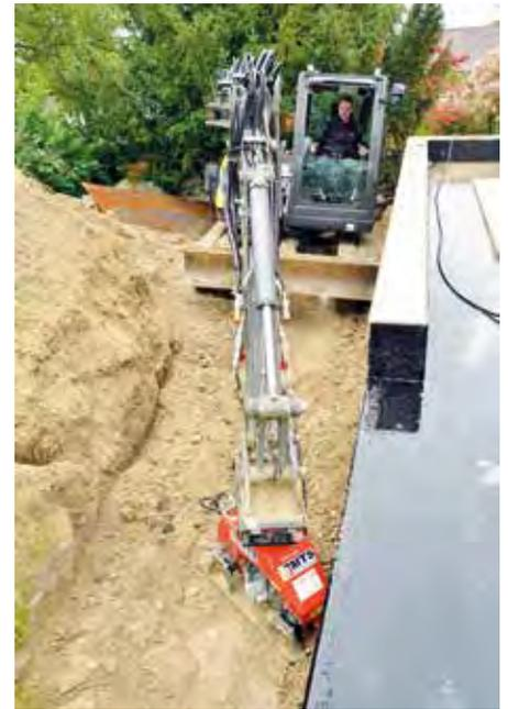
**Die enorme Reichweite** des Auslegers ermöglicht das Verdichten in unzugänglichen Bereichen.
