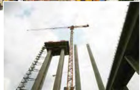
**Reife Leistung:** Ausgestattet mit dem leistungsstarken 75 LVF-Hubwerk war es den Kranen möglich, bis zu 18 m<sup>3</sup> pro Stunde zu betonieren.
