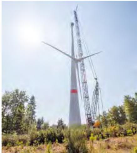
**Aufbau in nur drei Tagen:** Der am Boden vormontierte Rotor mit 68 t Gewicht wird auf die Nabenhöhe von 130 m gehievt.
