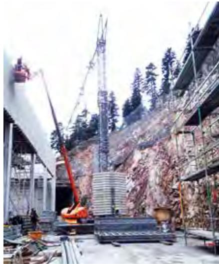
**Enger Arbeitsraum:** Dicht an der imposanten Felswand arbeiten die Turmdrehkrane KSD 4310 beim Bau eines Biomassen-Kraftwerks. (Fotos: BML)
