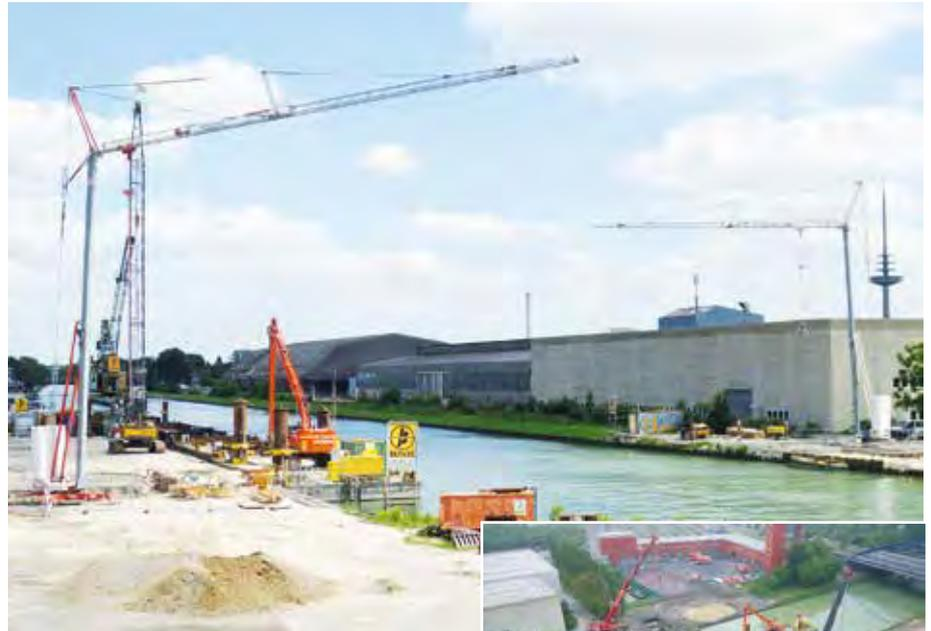
**Die beiden Turmdrehkrane** wurden zur Errichtung der Schachtbauwerke links und rechts des Weser-Ems-Kanals eingesetzt. Hier schleppten sie Lasten 15 m in die Tiefe und wieder nach oben. (Foto: Abrams-Vermietungen)
