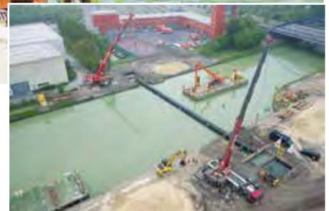
**Bevor die Turmdrehkrane** positioniert wurden, hieften zwei 350-t-Autokrane die 64 m langen Dükerrohre ins Kanalbett. (Foto: Johann Bunte Baunternehmung)
