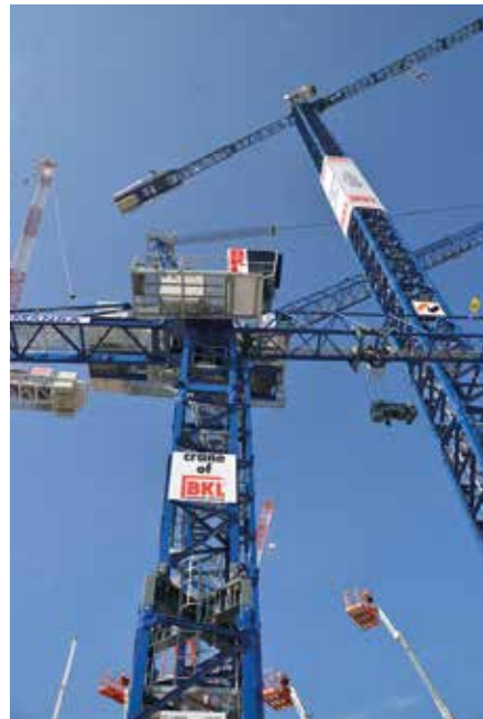
Im Bereich Obendreher investiert BKL in 15 neue Maschinen, darunter der mit 80 m Hakenhöhe und 80 m Ausladung höchste Baukran auf der Bauma 2016. (Fotos: BKL Baukran Logistik)
