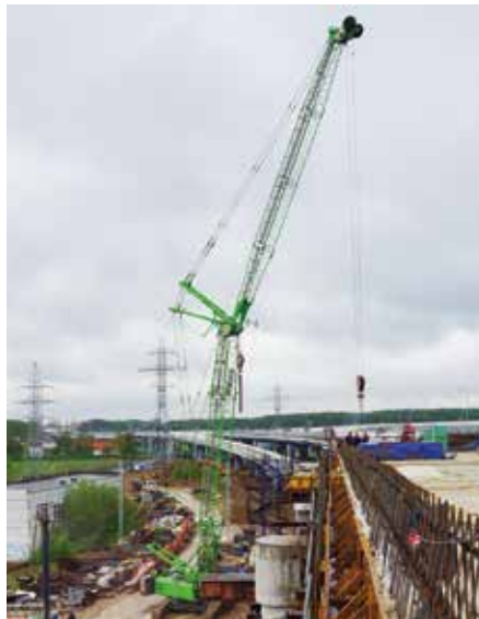
Während der dreijährigen Bauzeit hob der zuverlässige Raupenkran hunderte tonnenschwere Betonfertigteile ein. (Foto: Sennebogen)
