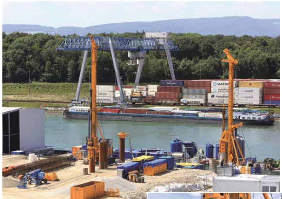
Sanierung im Zeitplan: Anfang Juli starteten die Großlochbohrungen für den Bodenaustausch und die Baugrube. (Pressefoto Roche)
