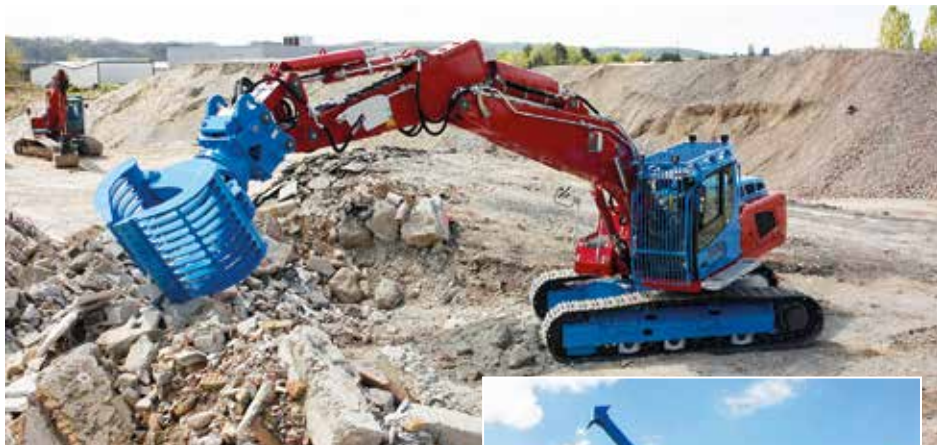
Maßarbeit: Der Raupenbagger wurde speziell an die Bedürfnisse von TP Bruetschy angepasst. (Fotos: Liebherr)
