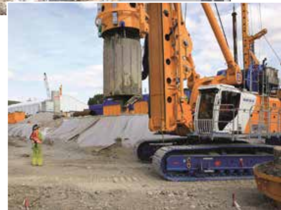
Sicherheit zählt: Die Mitarbeiter im unmittelbaren Bereich des kontaminierten Bohrguts werden mit einem eigenen umgebungs-luftunabhängigen Atemluftsystem versorgt. (Pressefoto Roche)
