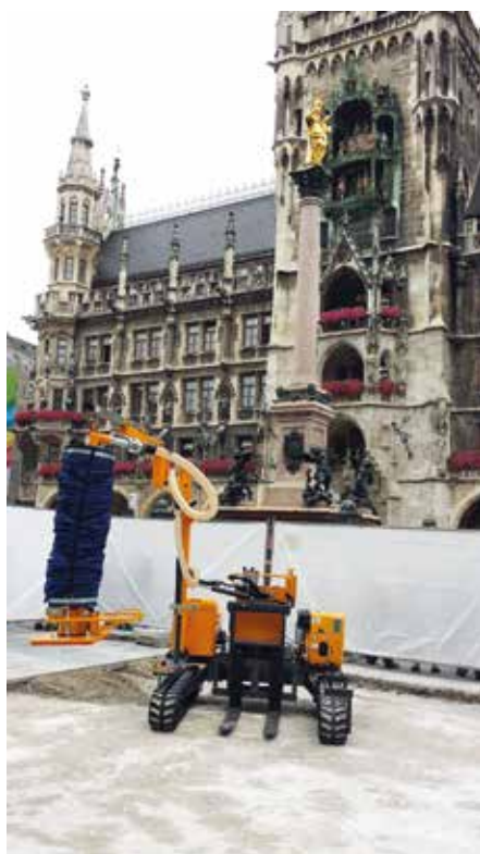
Vor malerischer Kulisse: Der Verlegetransporter Transmobil TM hilft beim Verlegen der neuen Granitplatte. (Fotos: Probst)
