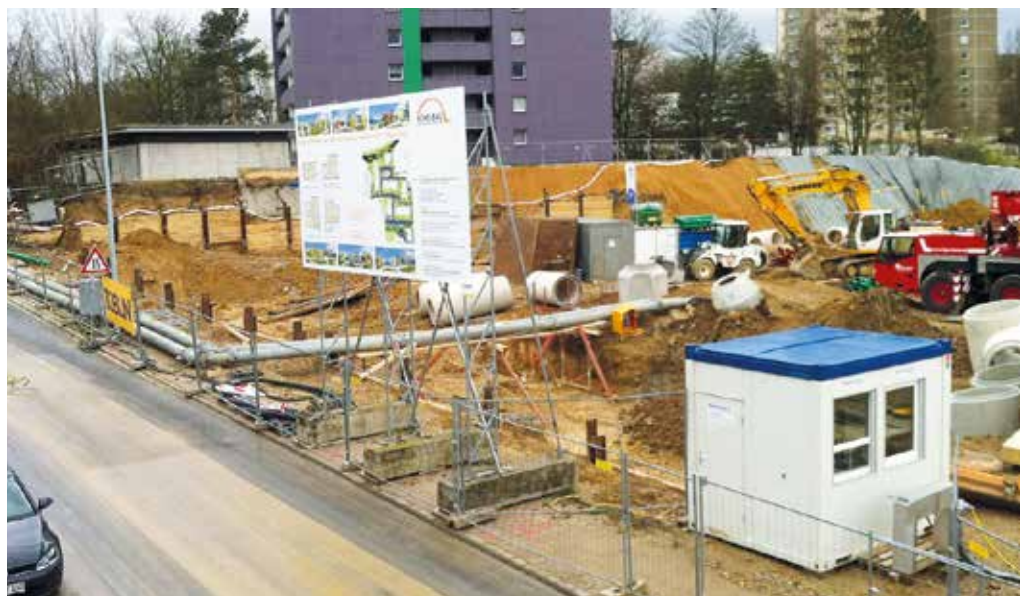
Schnelle Lösung: Beim Bauprojekt in Mainz bewährte sich wieder einmal der zuverlässige Xylem-Mietpumpenservice.
