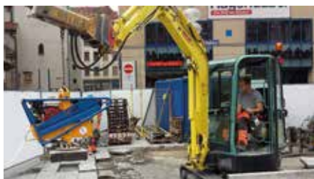
Alte Platten werden entfernt: Mit dem Vakuum-Anbaugerät SH-2500 lassen sich selbst die 250 kg schweren Granitplatten leicht und rückschonend anheben und versetzen.
