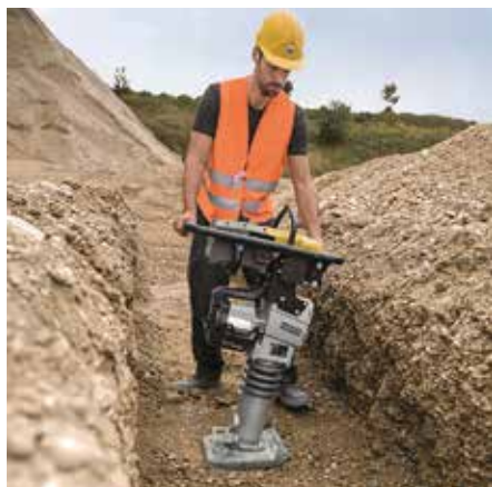
Die emissionsfreien Akkustampfer sparen durch den Betrieb mit Strom rund 55 Prozent der Energiekosten ein.
