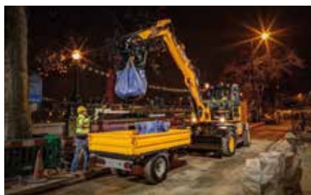
Mit Anhänger: perfektes und einfaches Baumaterial-Handling im innerstädtischen Straßenbau. (Foto: JCB)
