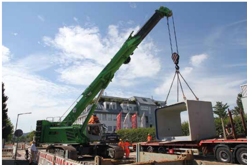
Hohe Traglast auf engstem Raum: Mit dem 120-t-Raupentelekrane baut Gollwitzer aus 30 t schweren Betonelementen einen unterirdischen Stauraumkanal. (Foto: Sennebogen)
