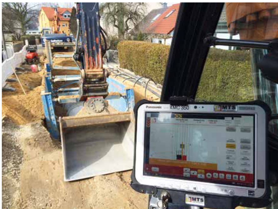
Dank MTS-Navi bekommt der Geräteführer via Display in Echtzeit die exakten Führungsvorgaben für seinen Baggerlöffel angezeigt.
