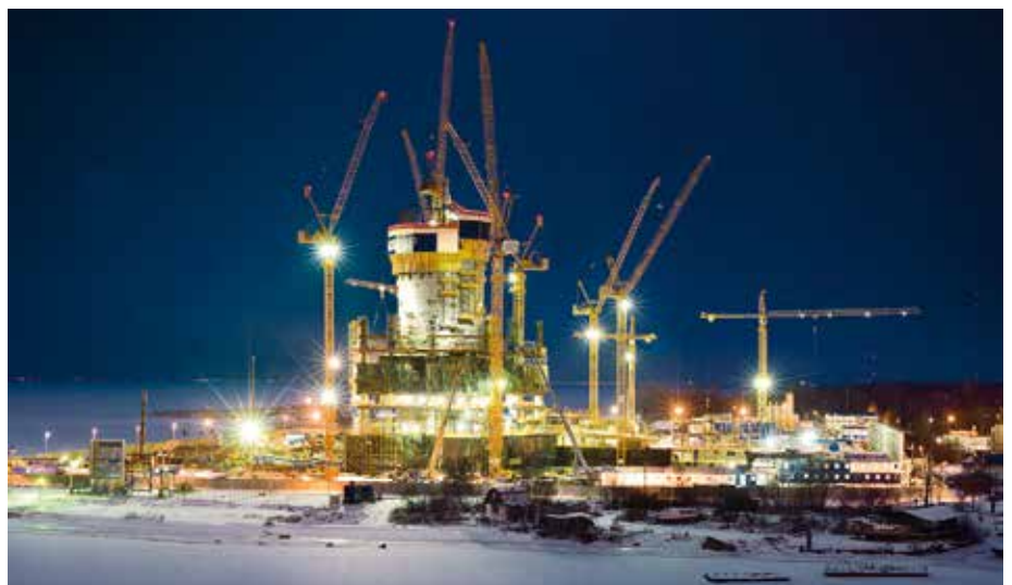
Die zehn Turmdrehkrane beim Bau des Lakhta Tower in St. Petersburg sind so angeordnet, dass sie auch unter beengten Platzverhältnissen frei drehen können.. (Foto: Liebherr)
