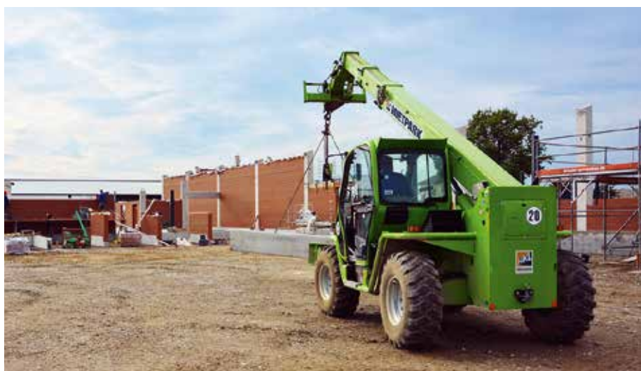
Teleskopmaschine von HKL transportiert schwere Betonpfeiler für den Bau einer neuen Reithalle in Durmersheim. (Fotos: HKL Baumaschinen)
