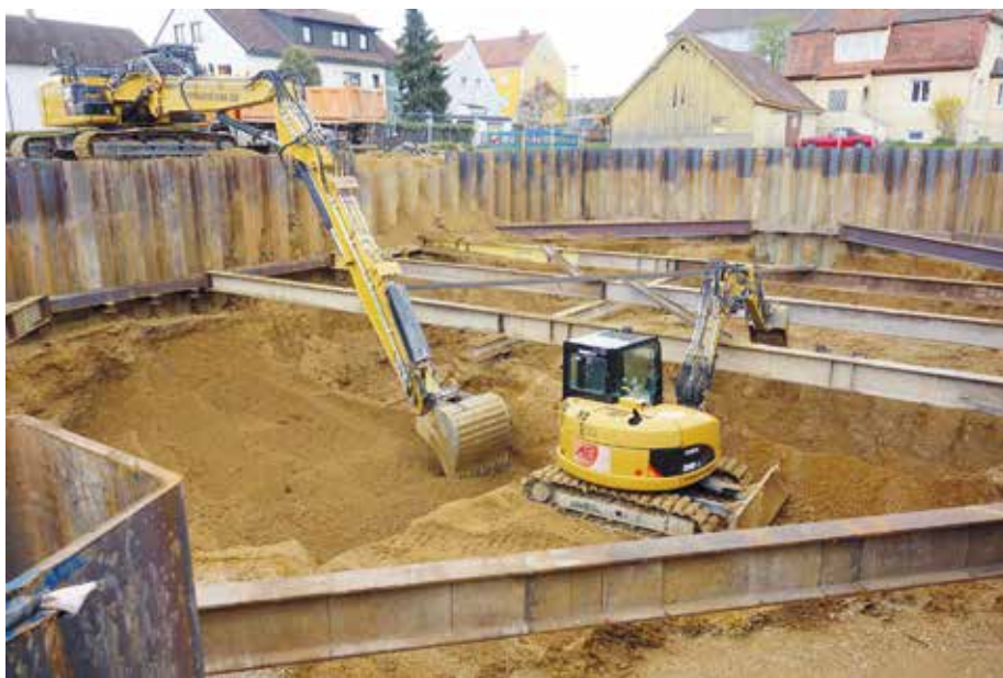
Beim Aushub wie in Nördlingen musste sich der Bagger bis zu einer Tiefe von 8 m vorarbeiten.
