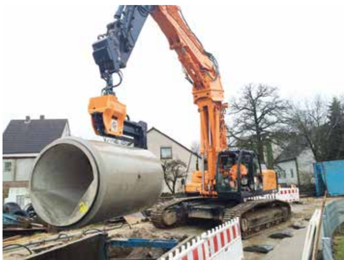
Mit dem Rohrverlegegerät RVG kann der Geräteführer die Arbeit vom Antransport über das Abhängen, Zwischenlagern und Wiederaufnehmen ganz alleine ausführen.
