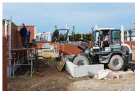
Ein Radlader bringt spezielle Klinkersteine heran, die zum Schutz der Pferde verwendet werden.
