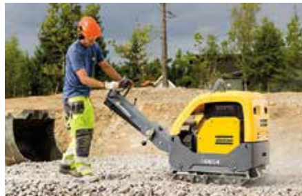
Die neuen Rüttelplatten entwickeln eine beeindruckende Traktion, insbesondere auf feuchtem Erdreich. (Foto: Atlas Copco)
