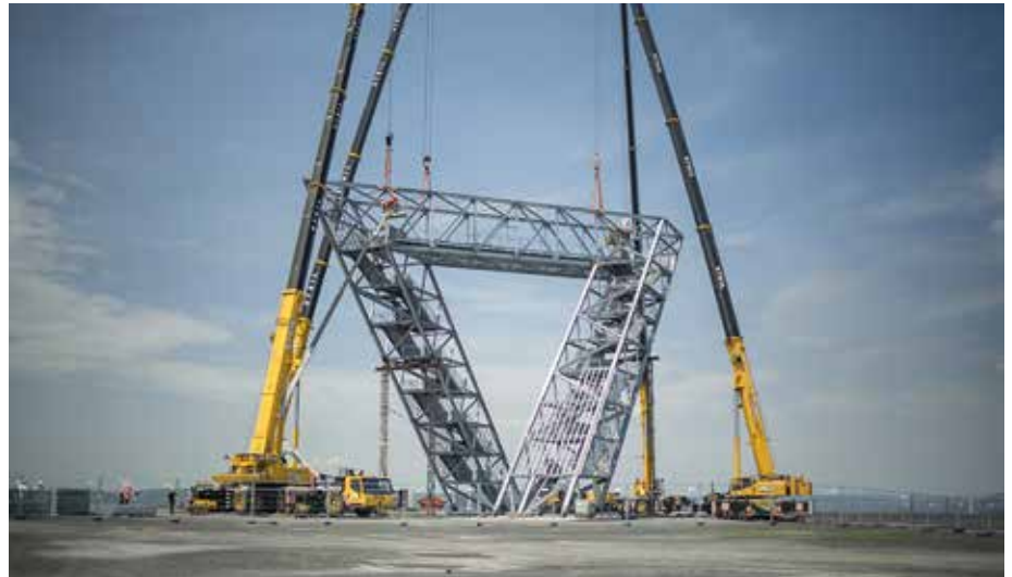
Zentimetergenau setzten der AC 200 und der AC 350 mit zwei weiteren Kranen die 35 m lange und 60 t schweren Aussichtsplattform zwischen die beiden Schrägtürme der begehbaren Großskulptur. (Foto: Terex)
