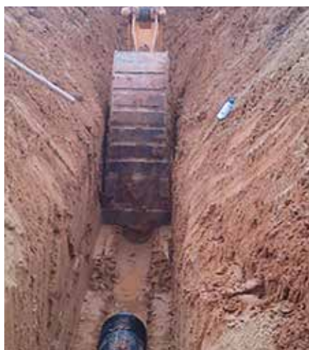
Eine Stahlzunge am Baggerlöffel ermöglicht den maßgenauen Aushub des Rohraufagers inklusive Seitenverfüllung. (Foto: Strabag)
