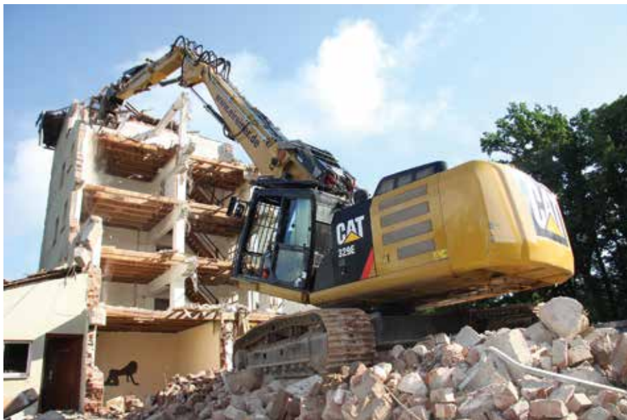
Der Cat 329E mit Spezialausleger ist maßgeschneidert für den Abbruch. (Fotos: Zeppelin)
