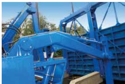
Überall einsetzbar: hier bei Arbeiten an einer Schleuse. (Foto: Hansa-Flex)
