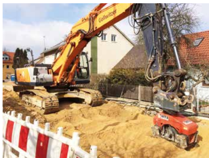
Durch Einsatz des MTS-Anbauverdichters kann der Baggerfahrer seinen Aufgaben ohne Unterbrechung nachgehen. (Fotos: MTS)
